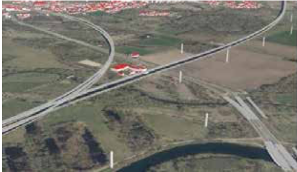
Abb. 17: ICE-Brückenbauwerk in der Saale-Elster-Aue in einer 3D-Modellierung. Dieser Teil der ICE-Strecke München-Berlin ist mit über 6 km Europas längste Fernbahnbrücke. Sie überspannt die besonders geschützte Auenlandschaft der Saale und Weißen Elster. Ebenfalls im Bild zu sehen ist eine parallel verlaufende Hochspannungsleitung. © GeoBasisDE/LVermGeo LSA, 2021.
