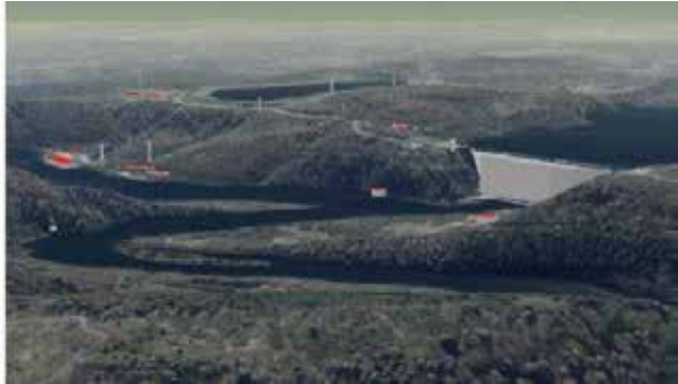
Abb. 18: Staumauer der Rappbodetalsperre im Harz. © GeoBasisDE/LVermGeo LSA, 2021.
